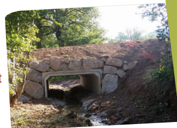
Pont cadre installé sur le Chandonnet
